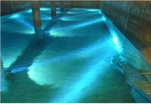
Trinkwasserhochbehälter am Herzberg. Foto: Norbert Strauß
